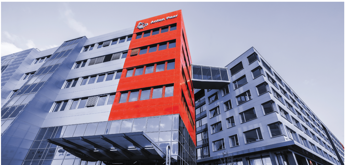
Le bâtiment principal et le centre technologique au siège de Graz
